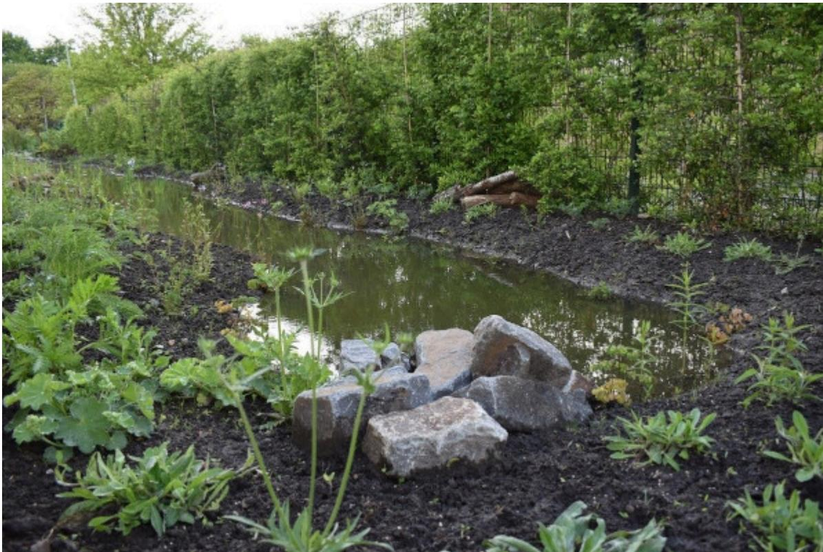
*Ein Regenwasserversickerungsgraben auf dem Betriebsgeländer von „Stadt. Land. Grün.“ in Brake nimmt das Niederschlagswasser von zwei Hallendächern auf. Der Zaun wird zum Spalier für heimische Pflanzen. Die Kanalisation wird entlastet, der Regen bleibt im natürlichen Wasserkreislauf. Das entstandene Biotop ist der Lebensraum für 30 verschiedene heimische Pflanzen, etliche Insekten und Amphibien. (Siehe auch [Regenwasserbewirtschaftung als Gewässerschutz](#))*
