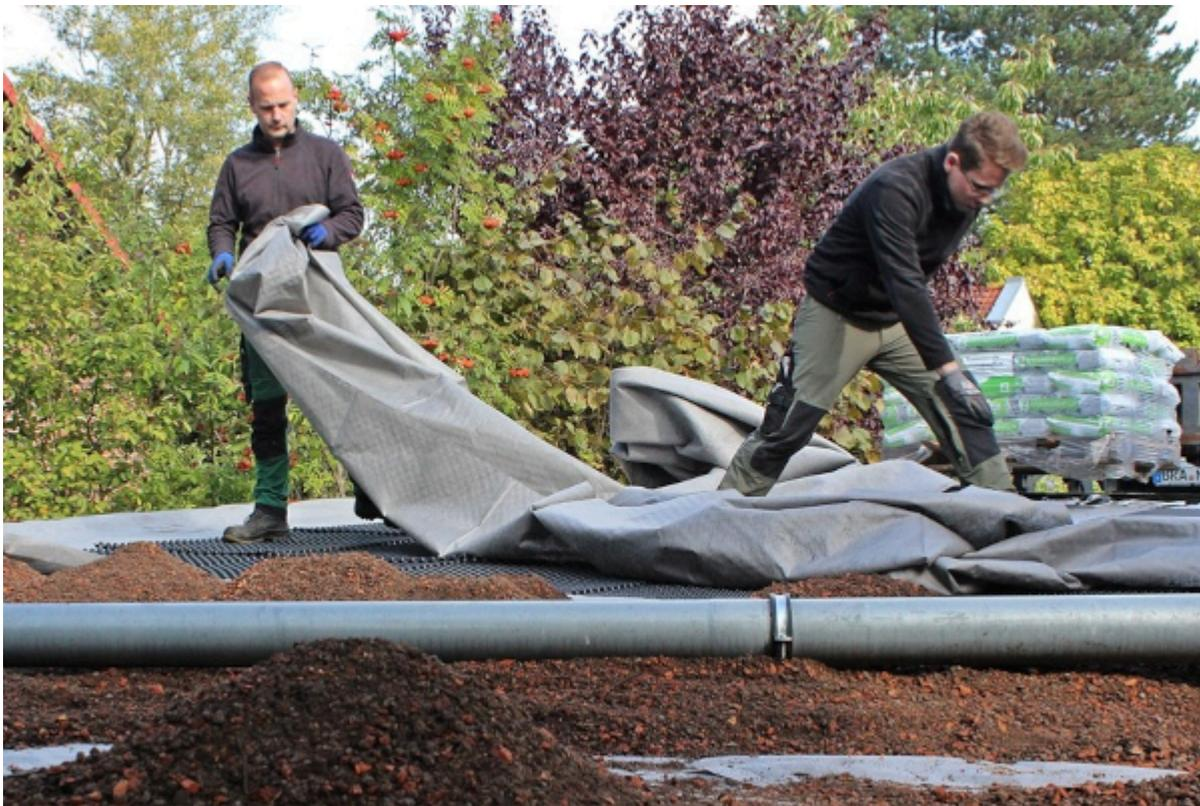
*Nachdem die Drainage-Elemente verlegt sind, werden sie mit Filtervlies bedeckt und so gegen die folgende Pflanzsubstratschicht abgegrenzt.*
