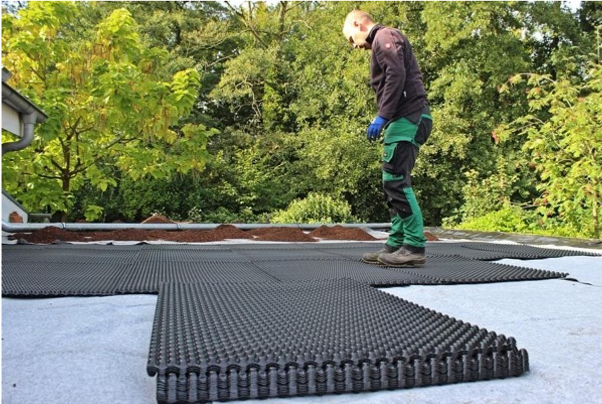
*Auf dem Speicherschutzvlies werden die wichtigen Drainage-Elemente verlegt. Sie werden im System die „wasserführende Schicht“ sein.*
