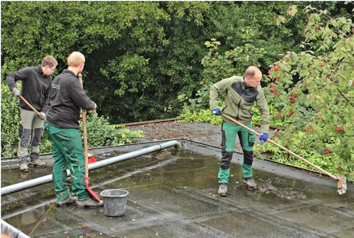
*Erst fegen, dann Wurzelschutz verlegen: Zunächst muss das Dach gründlich abgefegt werden, damit keine Steinchen die Wurzelschutzfolie von unten beschädigen. Das Team von Stadt. Land. Grün weiß, was zu tun ist*
