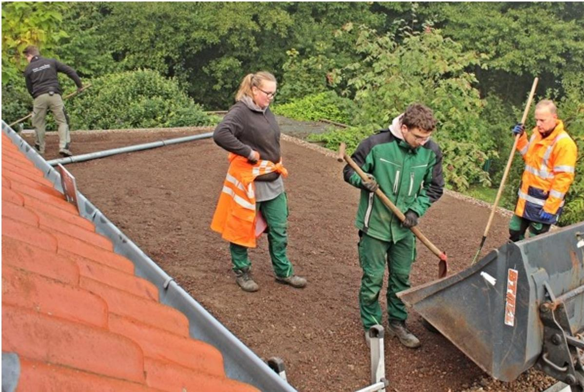
*Finish: Die Substratschicht „Steinrosenflur“ wird aufgetragen. Poröse Ton- und Vulkansteinbröckchen der Mischung erhöhen die Wasserspeicherfähigkeit (ähnlich wie bei Hydrokulturen).*
