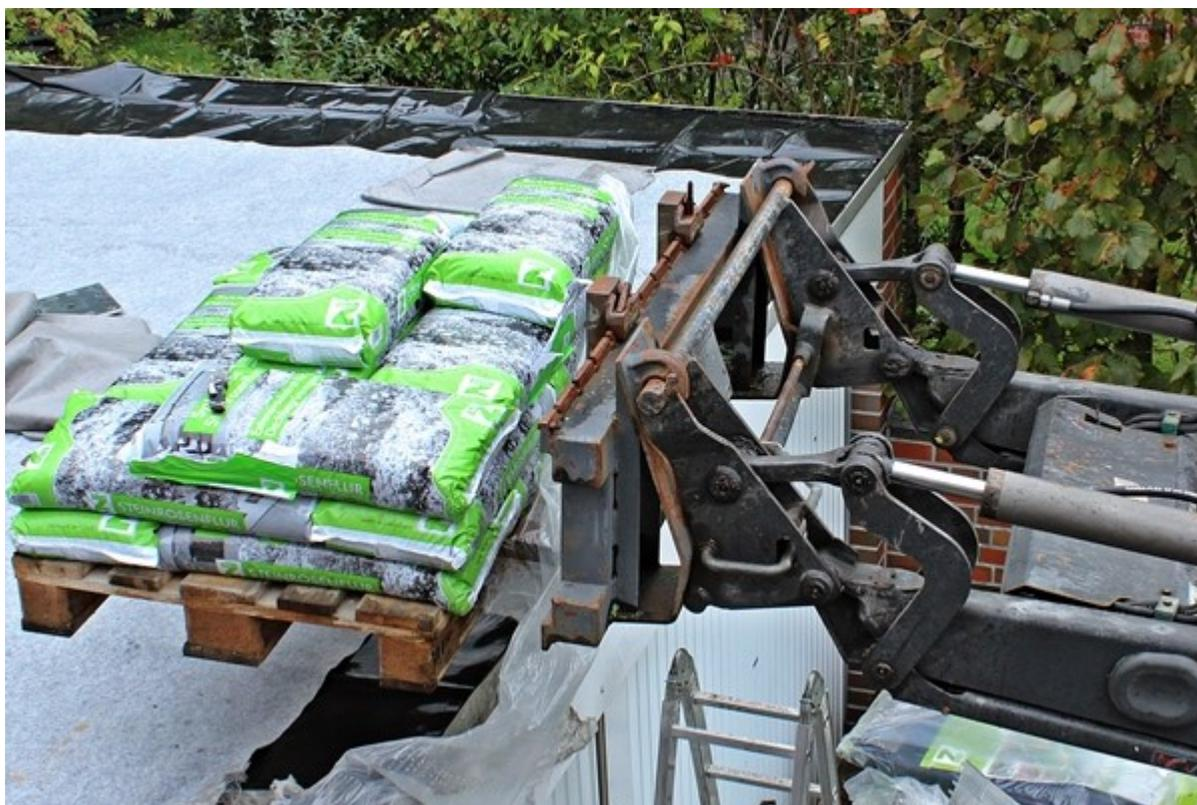
*Hilfreich: Was aufs Dach soll, gelangt durch Hubarbeit hinauf. Technische Unterstützung dabei ist empfehlenswert, bei über 50 m<sup>2</sup> kommen einige Tonnen Material zusammen. Die schwarze Wurzelschutzfolie ist verlegt, darauf ist die Speicherschutzmatte zu erkennen.*
