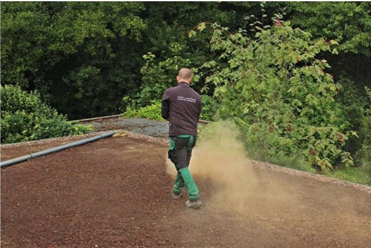
Detaillösung: Wasserablauf. Die Pflanzschicht ist in eine Kiesumrandung gebettet.
