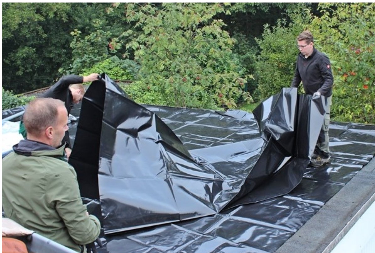
Grundlegend: Als erste Schicht im Systemaufbau wird die Wurzelschutzfolie verlegt.
