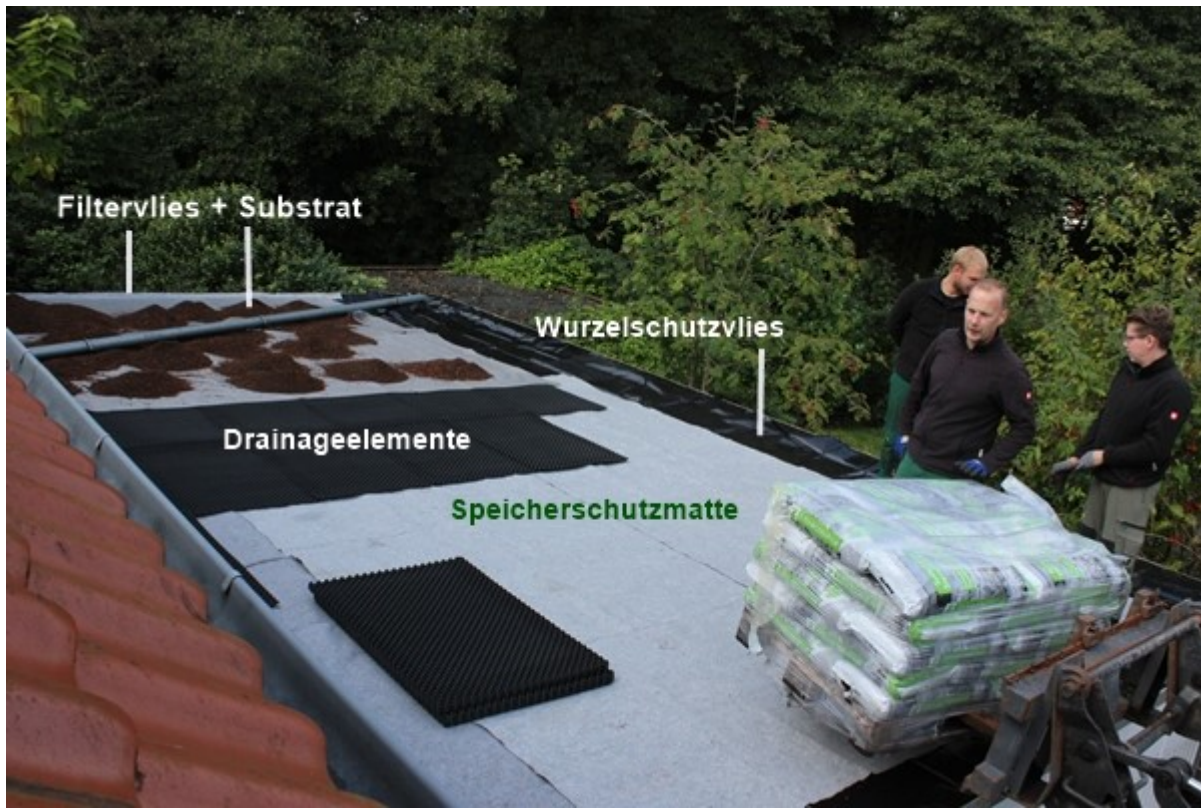
In dieser Arbeitsphase sind bereits alle fünf Systemkomponenten des Aufbaus zu sehen.
