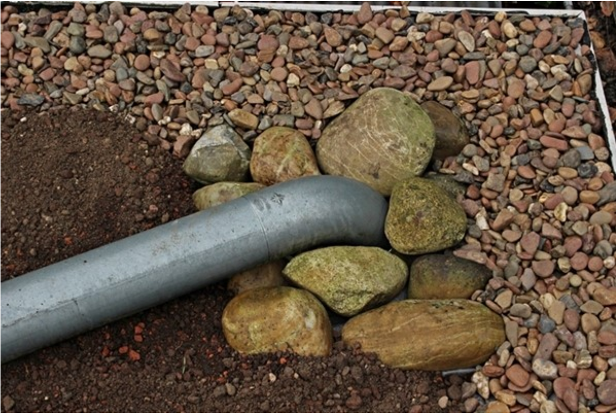
Detaillösung: Wasserablauf. Die Pflanzschicht ist in eine Kiesumrandung gebettet.
