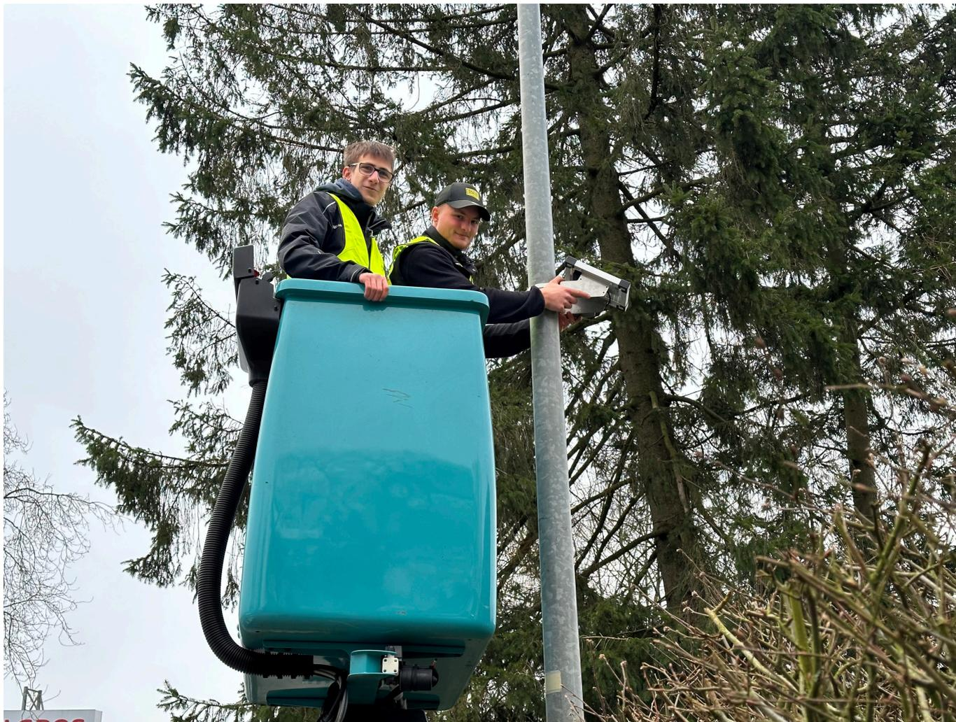
*Arbeiten in drei Metern Höhe: Hier wird eine Messsonde auf der Metjendorfer Landstraße installiert.*
