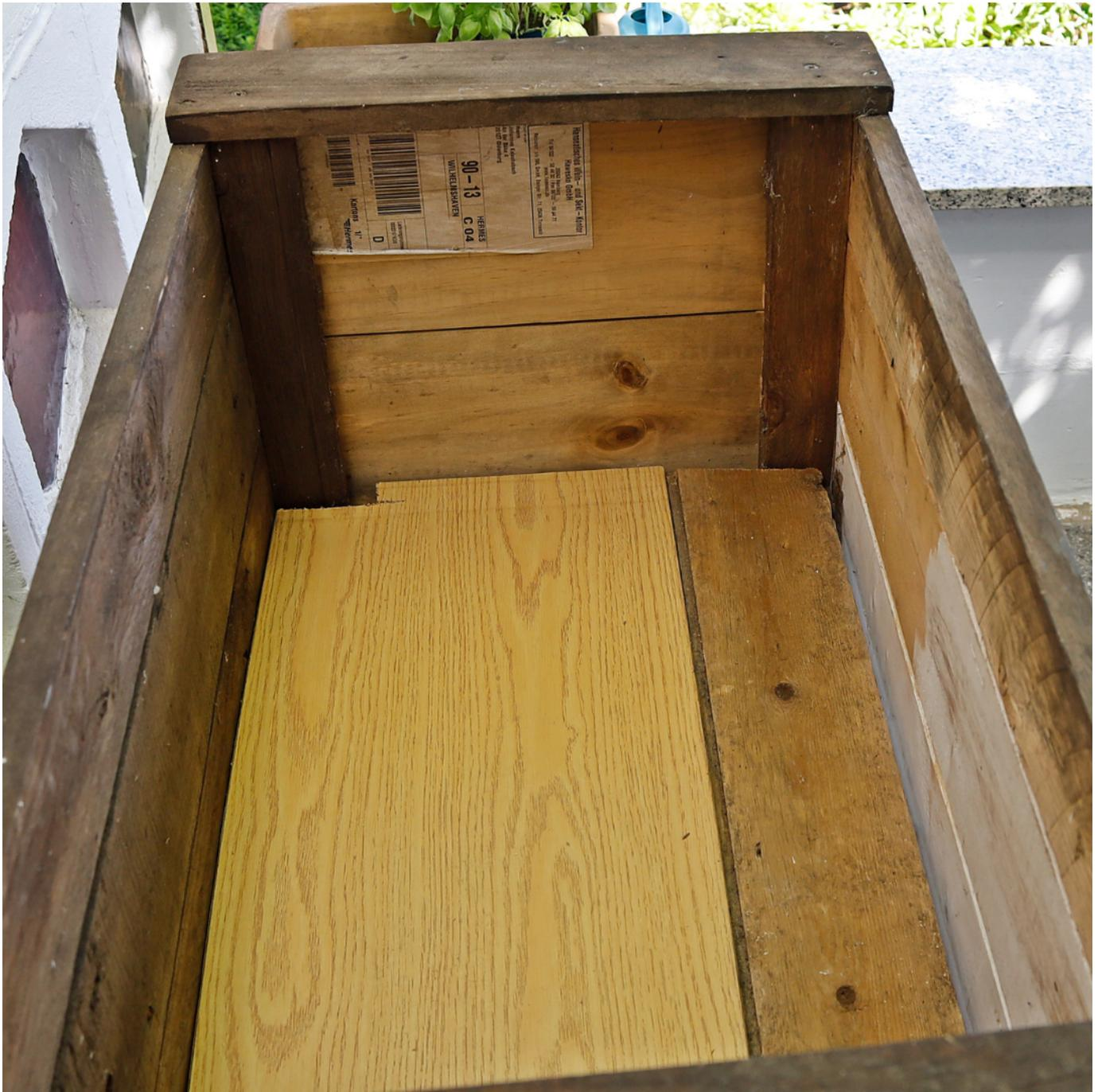
*Dass für den Boden hier neben einem soliden Vollholzbrett ein altes Regalbrett (Spanplatte Eiche hell) verwendet wurde, geht nur deshalb, weil die Terrasse überdacht ist und der Boden dadurch nicht nass wird. Anderenfalls müsste auch innen an Holzschutz gedacht werden. Vor Kopf sind einfache Sperrholzbretter einer Weinkiste als Verkleidung aufgenagelt, auch das geht nur, weil die Konstruktion nicht in der Bewitterung steht.*
